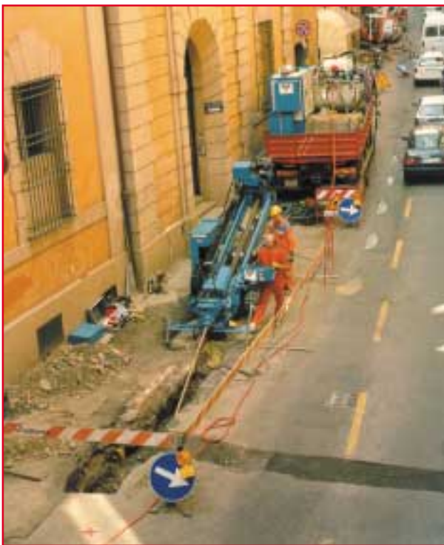
Fig.3 Cantiere no dig
