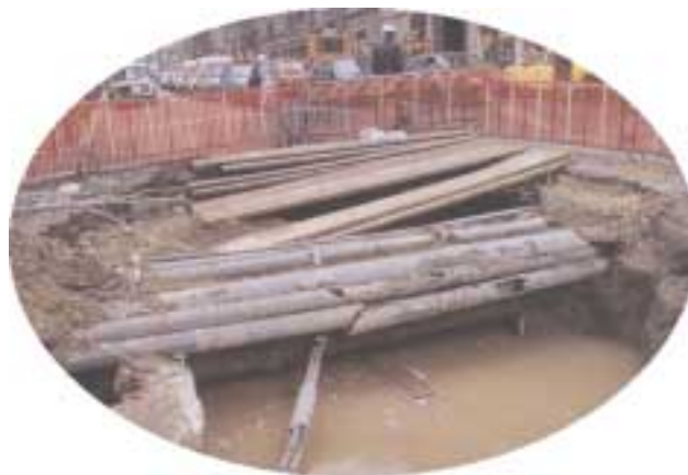
Fig.2 Scavo a cielo aperto
