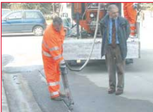
Fig.6 Cantiere microtrench
