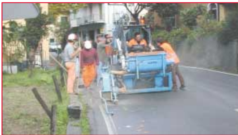
Fig.8 Scavo con tecnica minitrincea
